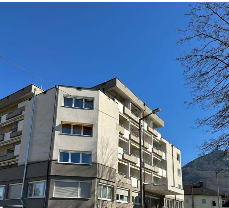
Außenansicht der Virgilambulanz der Caritas in Salzburg-Parsch. © Schwalb
